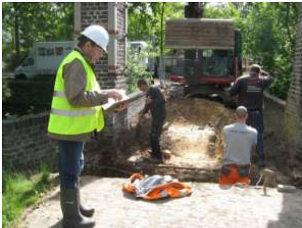
Anton Vissers bij het werk aan de kasteelbrug.
